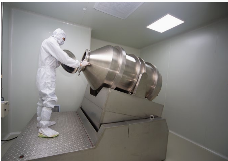
Công đoạn pha chế
